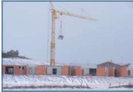
Janvier 2010 : la maison de retraite sort de terre.
